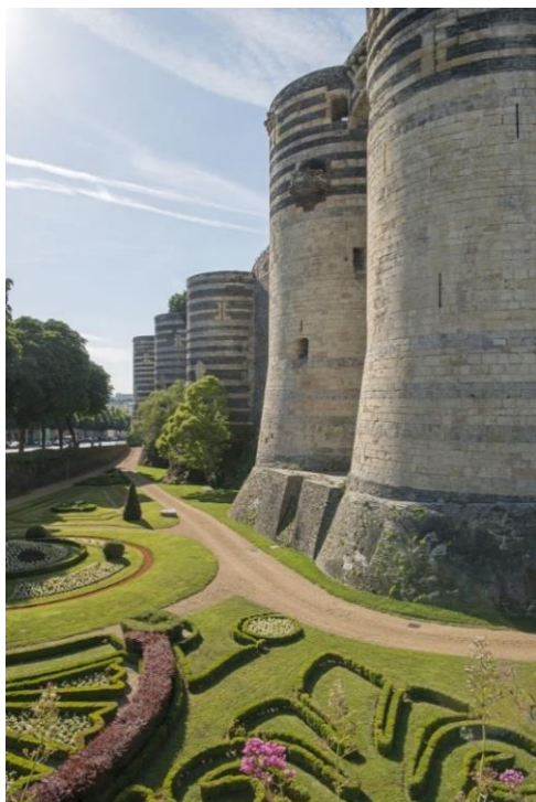
Château d'Angers, porte des Champs, tours sud-ouest et jardin des fossés © Jean-Pierre DELAGARDE
