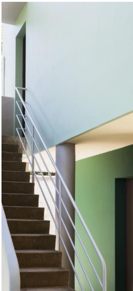
Villa Savoye, maison du jardinier, escalier d'accès au premier étage © Laurent Gueneau/CMN
