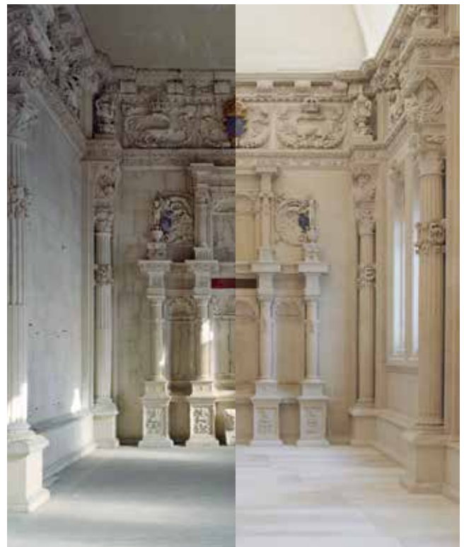
Chapelle avant et après restauration © Thomas Jorion - CMN ; Benjamin Gavaudo - CMN
