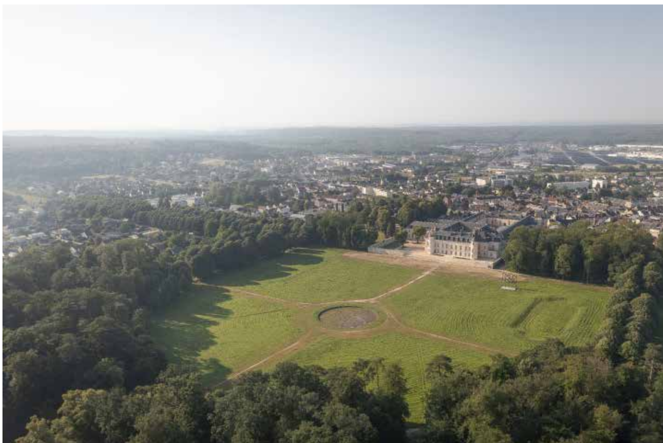
Vue aérienne du château de Villers-Cotterêts et de son parc © Yann Monel - CMN
