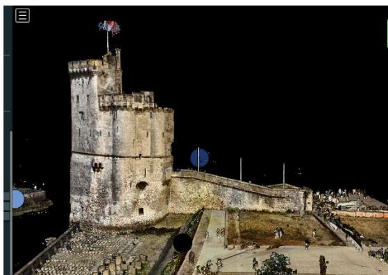
Tour Saint Nicolas de la Rochelle Travaux de sondage
