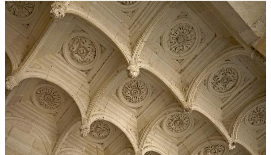
Détails de l'escalier du château d'Azay-le-Rideau
