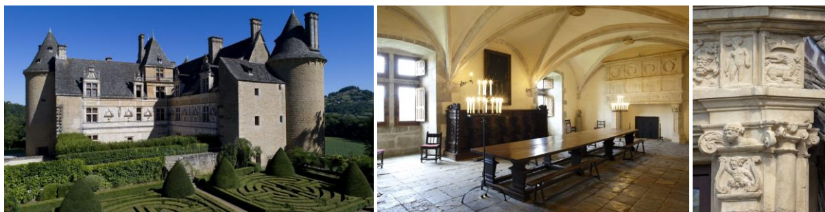
Château de Montal, façades sur cour / grande salle / détail de la deuxième lucarne de la façade sud-est après restauration © David Bordes – CMN
