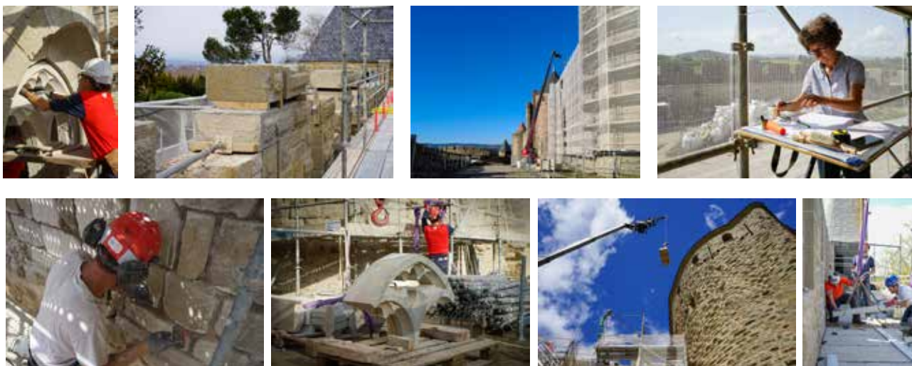
Chantier de restauration des remparts © Catherine Jeanjean - CMN.
