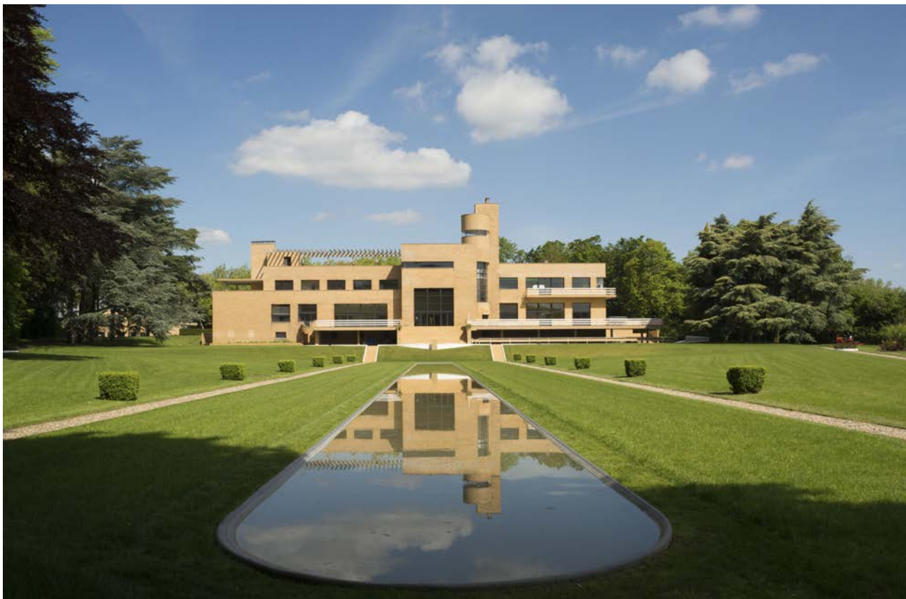
Villa Cavrois, vue d'ensemble de la façade sud depuis l'extrémité du miroir d'eau © Jean-Christophe Ballot
