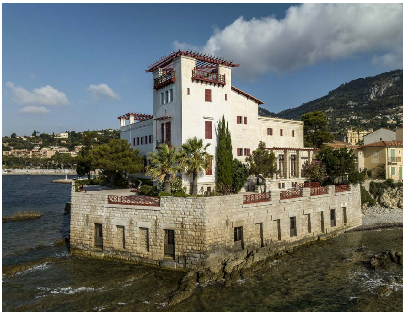
Vue aérienne de la Villa Kérylos © We are Content
