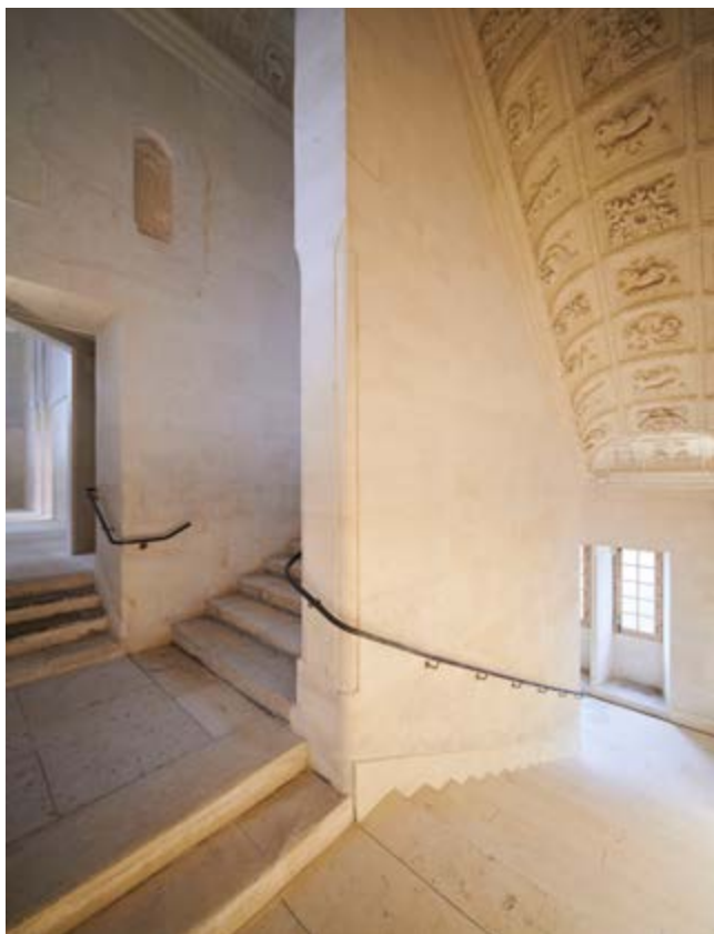
Escalier du Roi restauré © Benjamin Gavaudo - CMN
