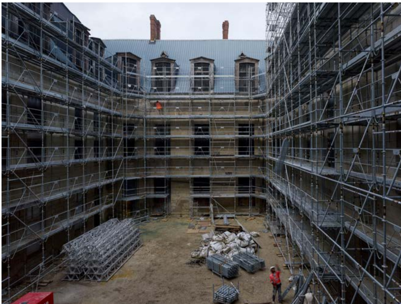
Chantier et montage des échafaudages du Logis royal © Pierre-Olivier Deschamps / Agence Vu' - CMN
